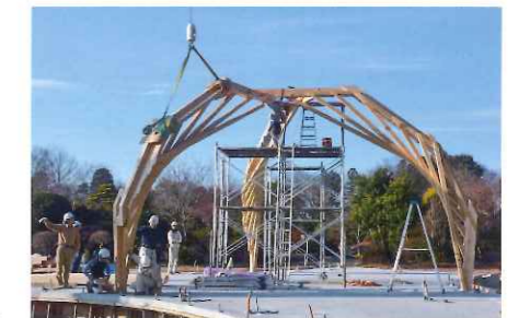
基本となる3つの組柱の施工段階。
