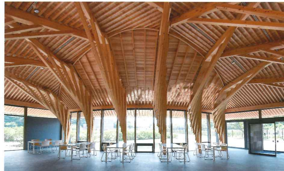
内陣から池側を見る。相持ちによる105角ヒノキ材の架構。
