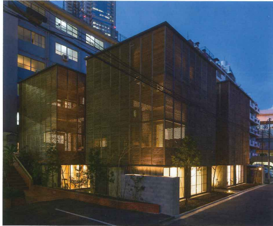
南側外観夜景。4戸の分棟長屋形式の集合住宅。
