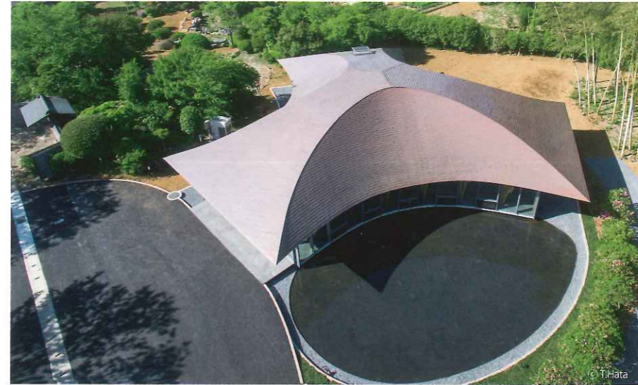
南側より俯瞰。屋根は3つの方向に延びる。
